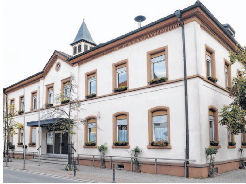
Das Altlußheimer Rathaus soll mit Landeszuschüssen saniert werden. BILD: SCHWERDT
